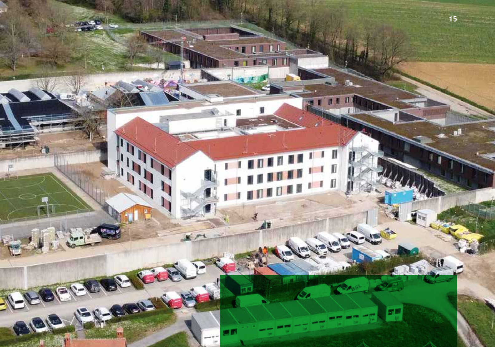
Nach 3-jähriger Planungs- und Bauzeit wird das neue Maßregelvollzugsgebäude in Anwesenheit von Minister Manfred Lucha eröffnet werden.
