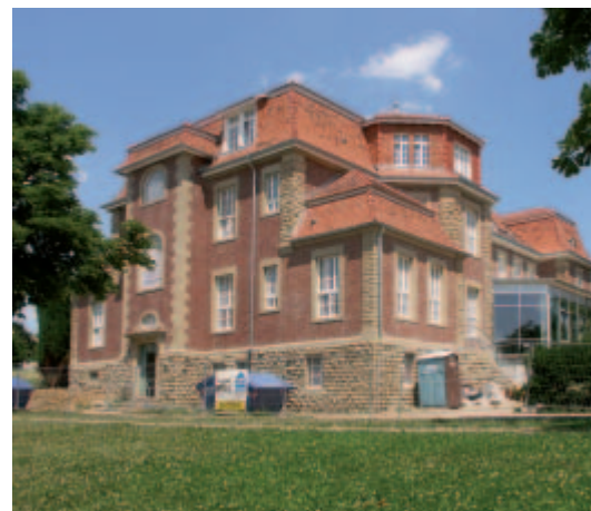
Die Bauarbeiten an der Station 05 werden mit Hochdruck voran getrieben
