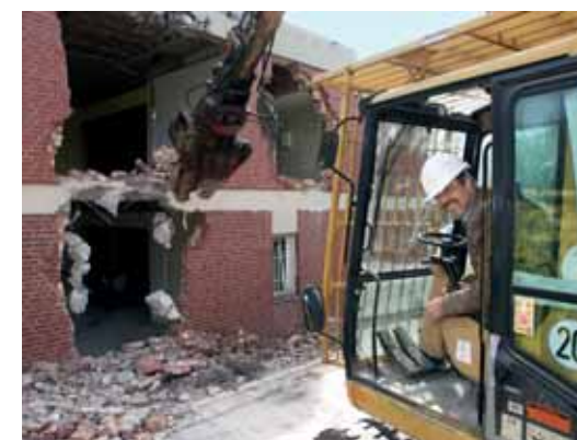
Geschäftsführer Fliß im Abrissbagger
