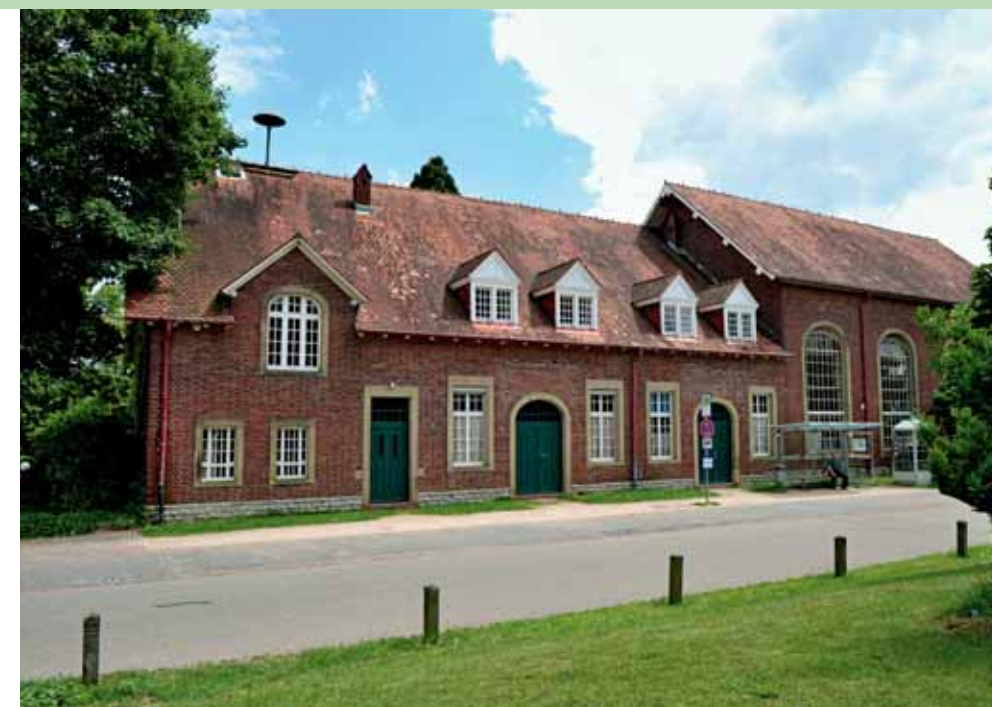
Das Gebäude 26 wird bald ein Ärztehaus
