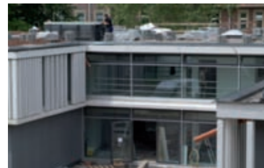
Noch herrscht Baustellenbetrieb
