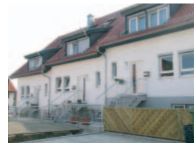
Reihenhäuser Südliche Zufahrt
