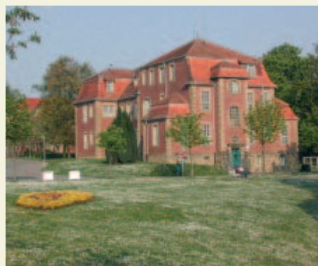
2004 - Die gleiche Station 05 - sie wird in naher Zukunft für die forensische Abteilung renoviert
