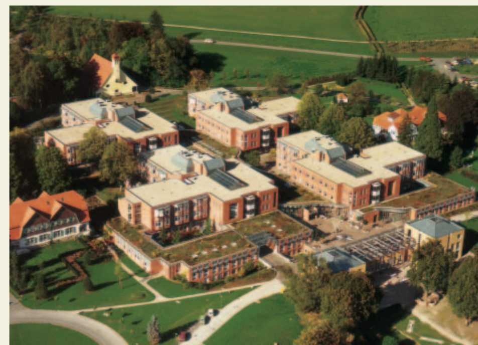
Luftaufnahme des zentralen Aufnahme- und Behandlungsgebäudes
